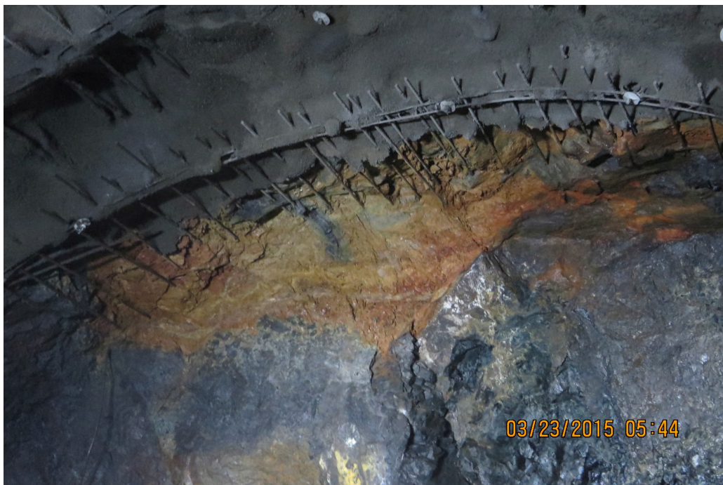
Mynd 5.6: Dæmi um uppsettan sprautusteypuboga í Vaðlaheiðargöngum ásamt forboltum (Sigurjón Vídalín, 2016a).
