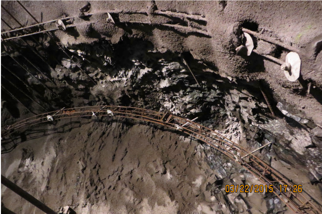
Mynd 5.8: Uppsettir grindarbogar í Vaðlaheiðargöngum (Sigurjón Vídalín, 2016a).
